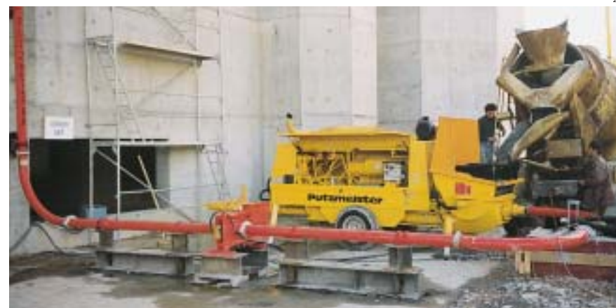
Tuyauteries ZX haute pression, jusqu'à 250 bar – indispensables dans le bâtiment
