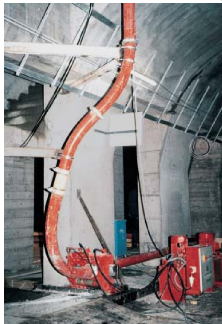
Tiroir d'arrêt avec centrale hydraulique et armoire de commande. Pilotage possible par télécommande
