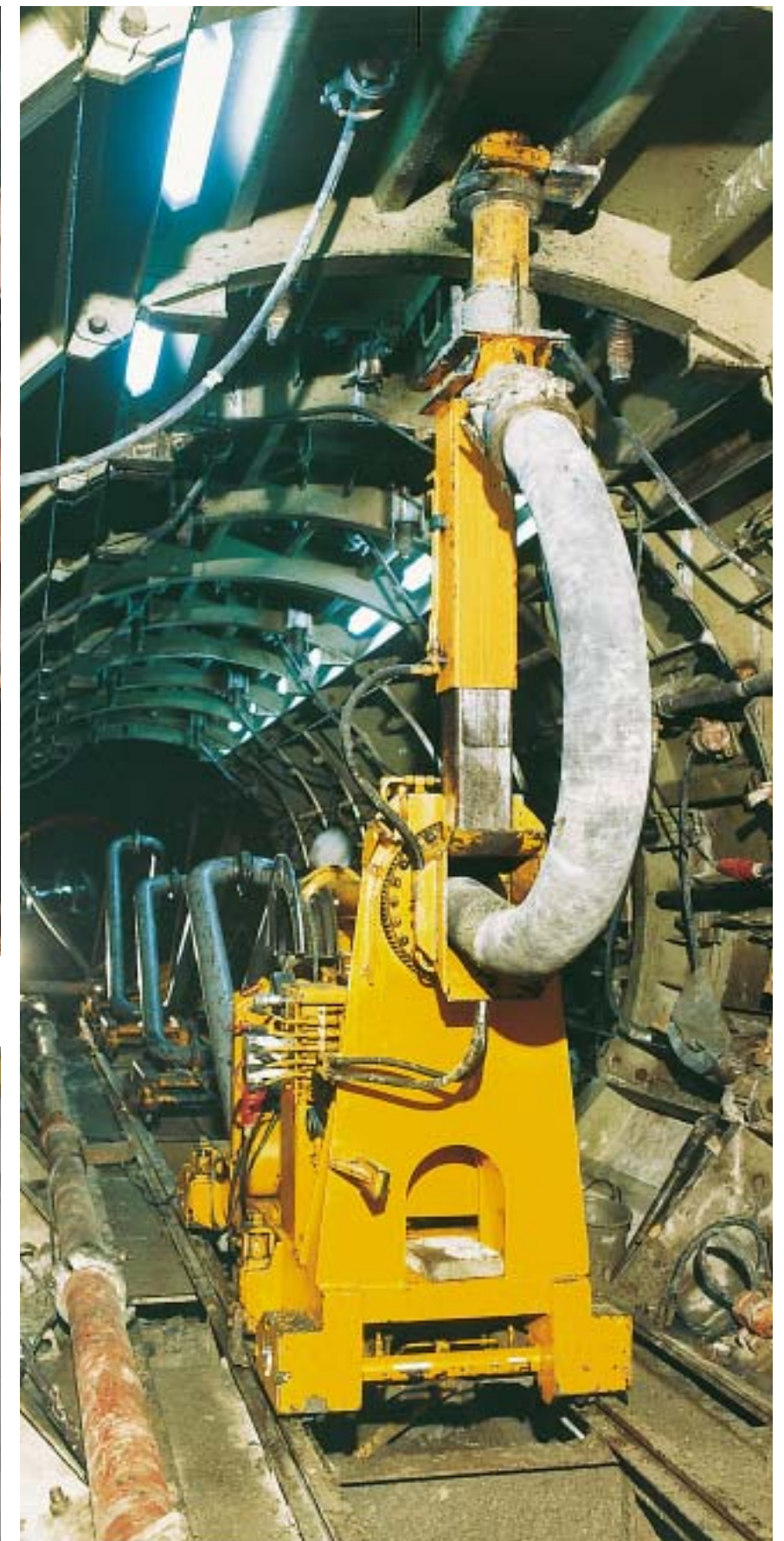
Bétonnage en tunnel avec des tuyauteries flexibles SK servant de tuyaux ciseaux
