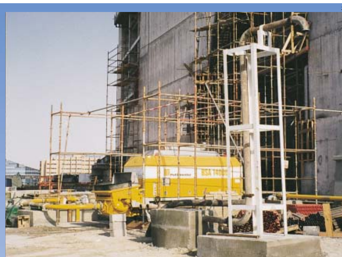
Pompage en hauteur avec des tuyauteries ZX, ici avec station de nettoyage
