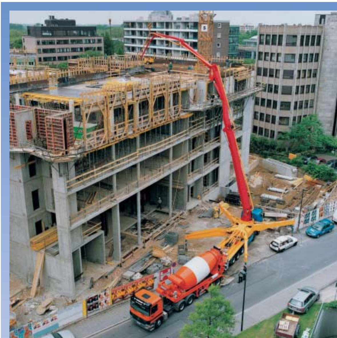
Indispensables en cas de pompes à grande flèche et de débits importants. La tuyauterie PROLINE Putzmeister.
