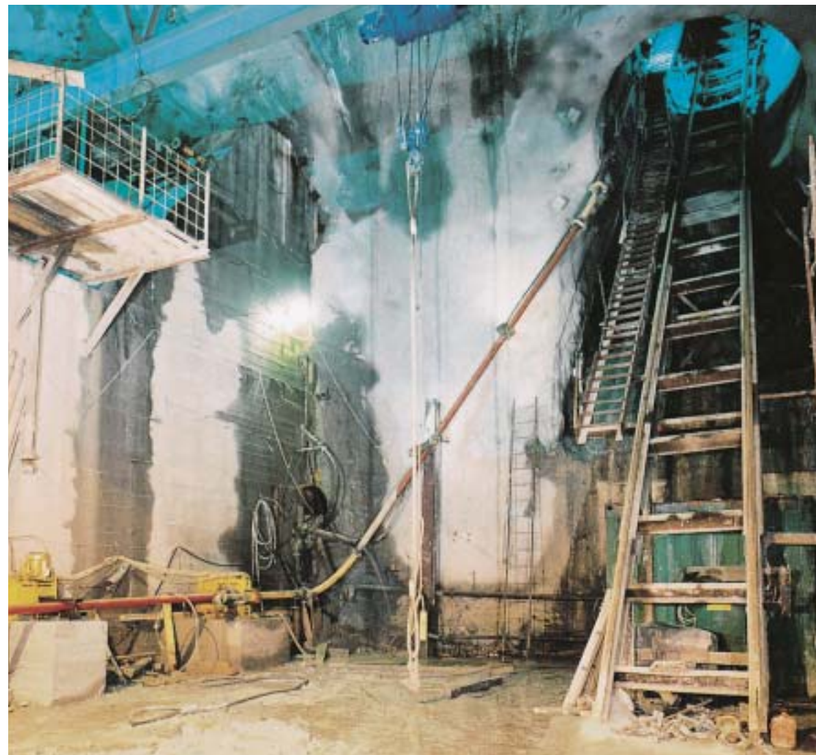
Record du monde: du béton pompé à une hauteur de 532 m avec une tuyauterie ZX 100, 250 bar
