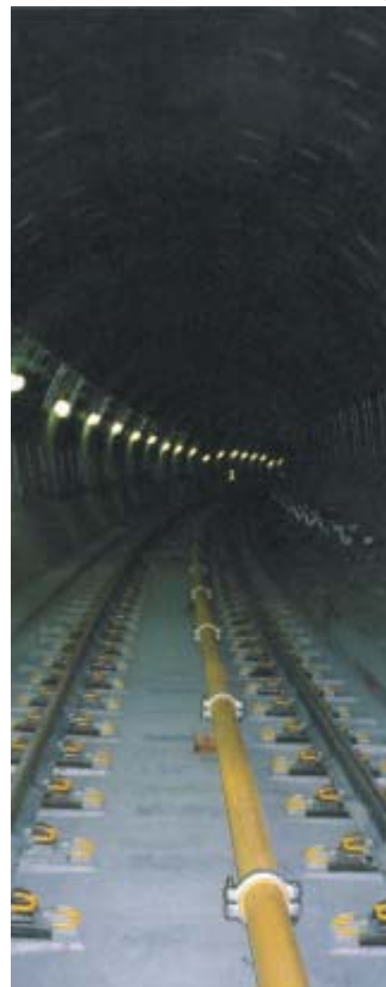
Avec le système Zentrifix® vous installez de manière sûre des tuyauteries horizontales de grande longueur
