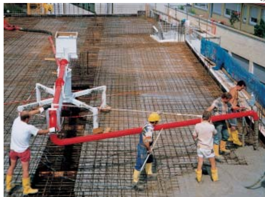
Épandeur giratoire RV 10. Les épandeurs giratoires sont livrables à partir du RV 0 jusqu'au RV 22 en différentes exécutions
