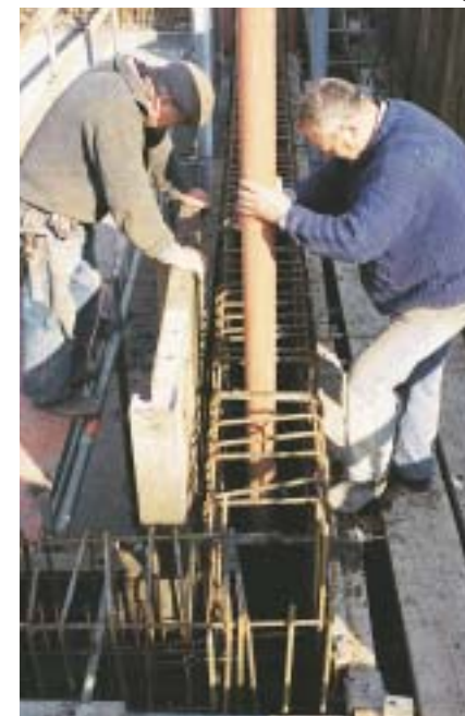
Réduction pour des tuyaux plastiques. Idéale pour des coffrages étroits
