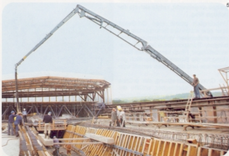
Präzise Fernsteuerung beim Befüllen der stark armierten Schalung des Brückenkastens.
