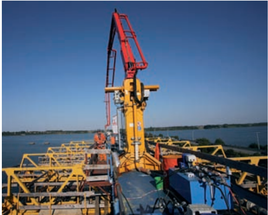
Stationärmast MX 24 auf der Vorschubrüstung
